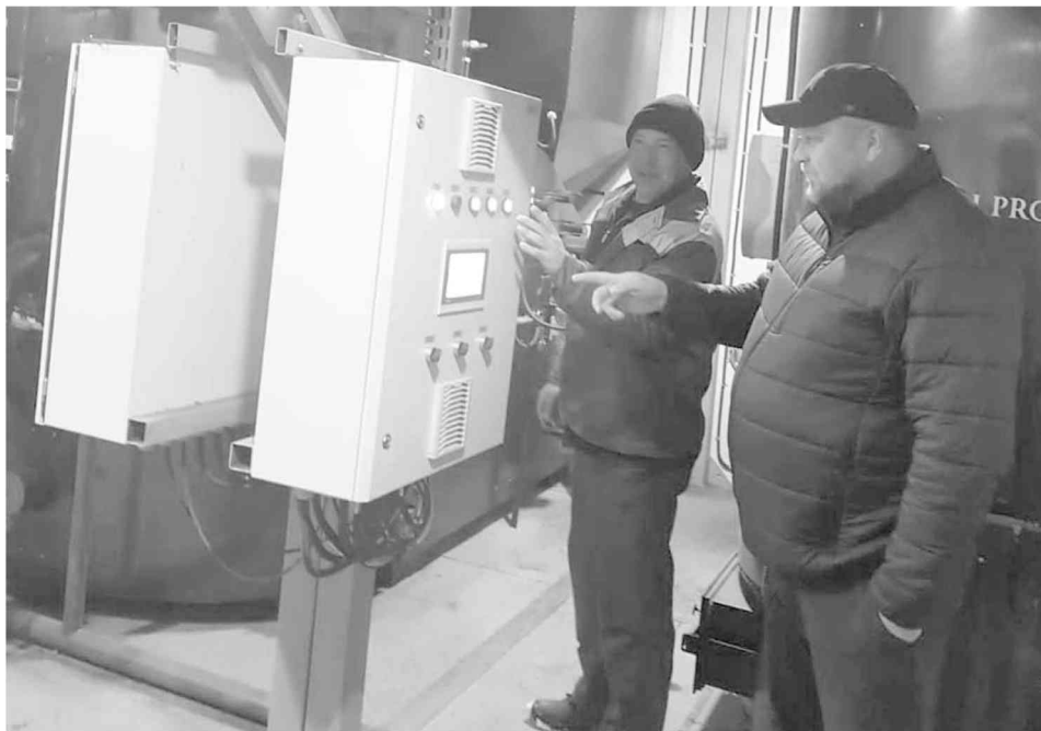
Тестирование оборудования на котельной в Екатериновке
