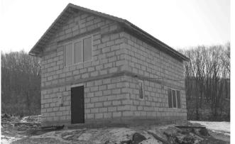
в селе без огорода? Возводить просторный дом из газоблоков начали в мае 2024-го. С нанятой строительной бригадой повезло: таджикские строители показали себя отличными профессионалами, и осенью дом был уже под крышей. До зимы успели установить окна и двери, «черновую» электропроводку и систему отопления, выровняли стены, пробурили скважину. Остались отделочные работы, на которые также потребуется
